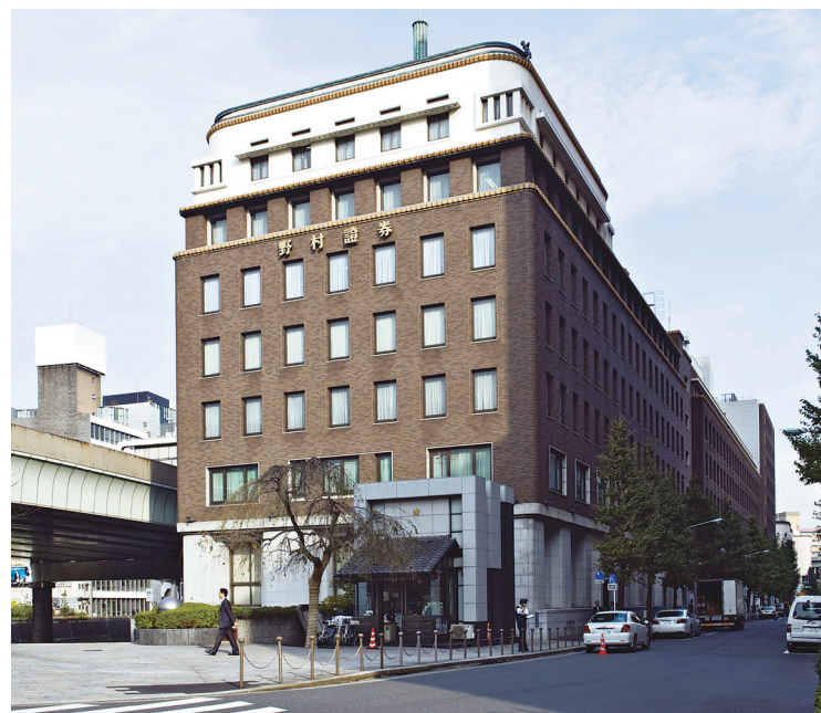
顧客本位の営業姿勢の徹底を図る野村證券（東京・日本橋の本社ビル）
